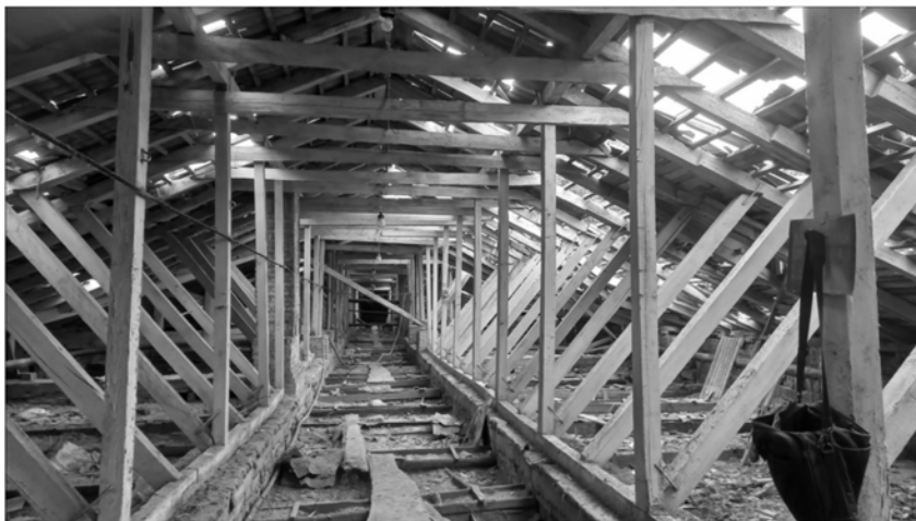
Фото 1. Загальний вигляд даху корпусу
