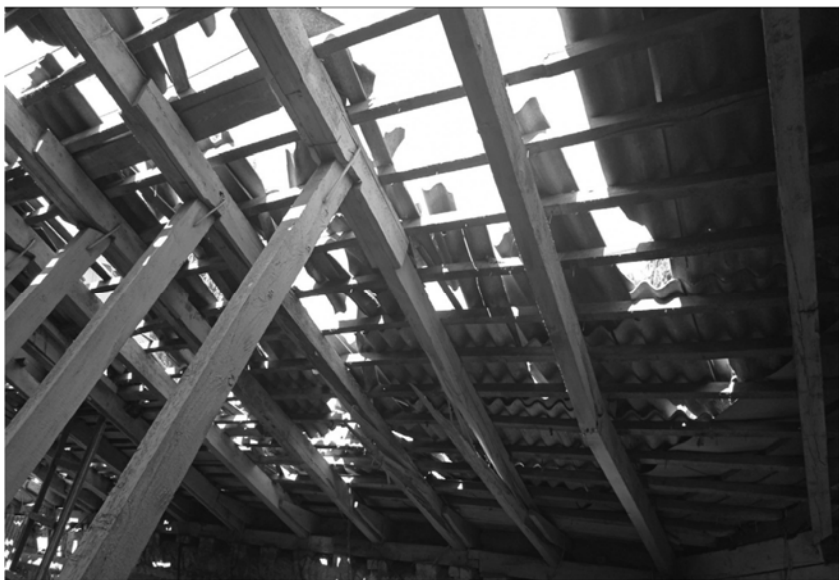
Фото 2. Вигляд покрівлі і даху в осях В-Г/5-6
