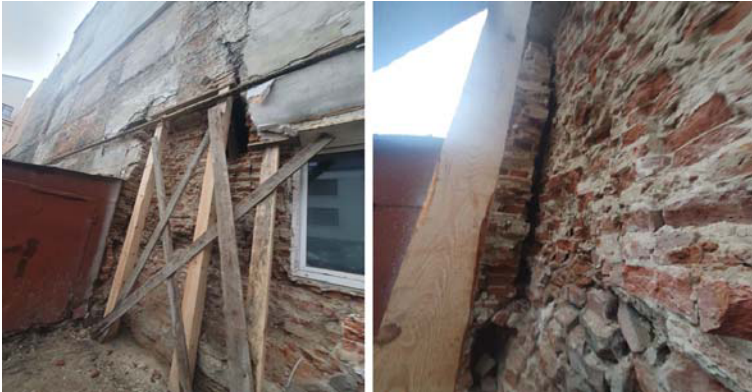
Рис. 3. Втрата стійкості несучої стіни по осі 1, в осях В-Е
