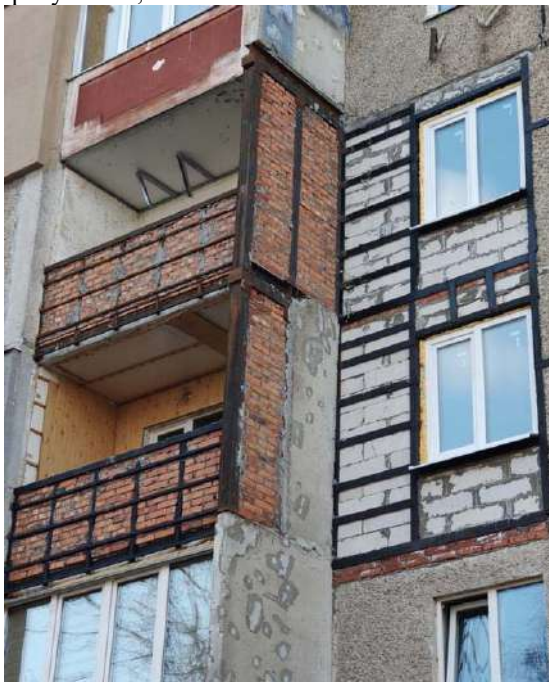
Рис. 1. Підсилення зовнішніх стінових панелей металевим каркасом
