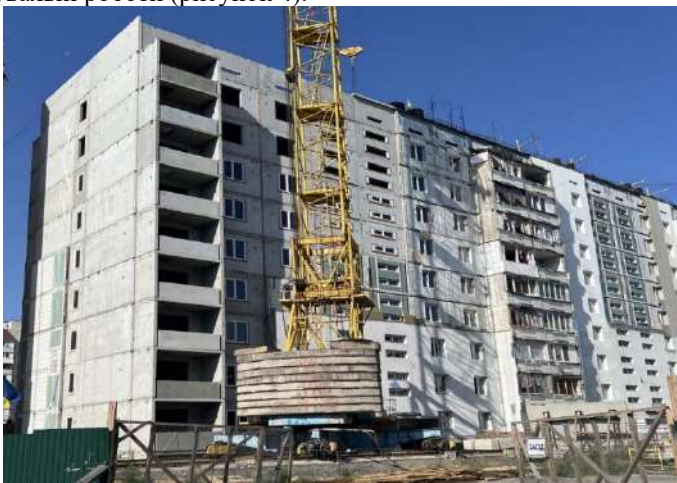
Рис. 4. Закінчення монтажних робіт та виконання робіт з утеплення будинку (кінець 2024 року)
