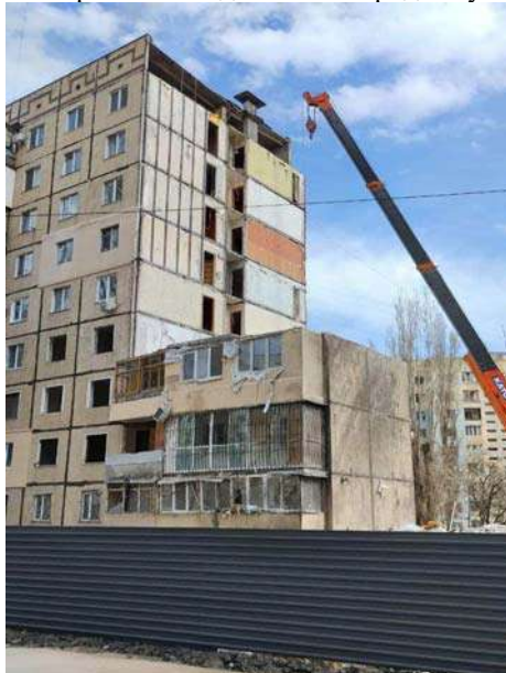
Рис. 5. Загальний вид частини будинку на просп. Добровольського, 134 в м. Одеса після закінчення робіт із демонтажу аварійних конструкцій
