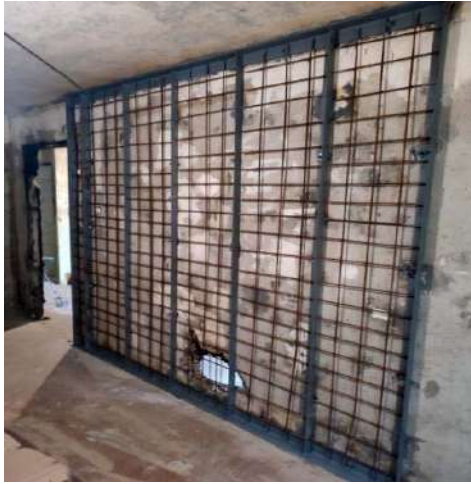
Рис. 2 .Металевий каркас підсилення внутрішньої стінової панелі
