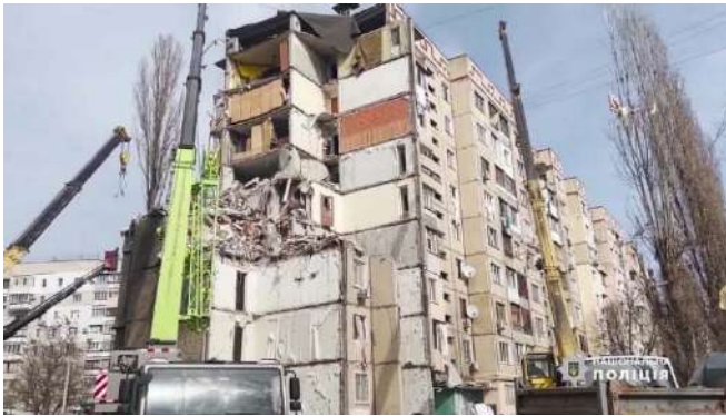
Рис. 5. Загальний вид на руйнування частини 9-поверхового панельного будинку в м. Одеса на просп. Добровольського, 134
