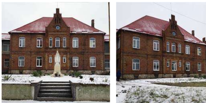
Рис. 1. Фасад будівлі лікарні (теперішній стан)
