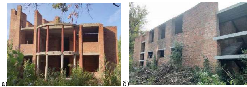
Рис. 1 – Загальний вигляд фасадів громадської будівлі
