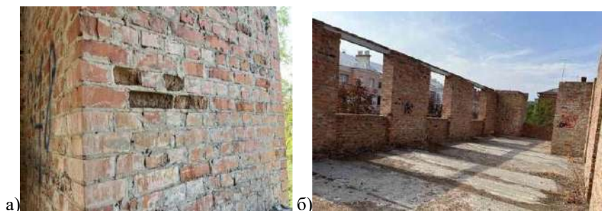
Рис. 3 – Причини пришвидшення морозобійного руйнування цегляної кладки: а) різна пористість цегли; б) незахищеність від атмосферних опадів
