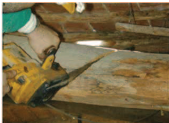
Рис. 2. Видалення гнилої частини.
