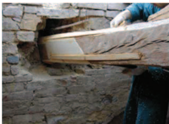
Рис. 6. Вставка додаткових дерев'яних елементів
