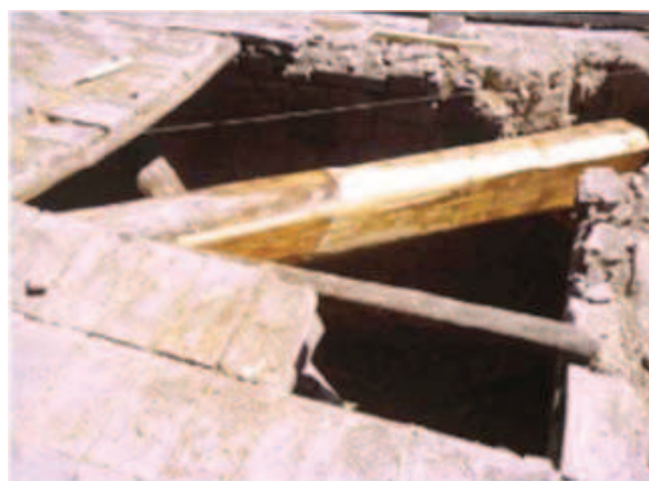
Рис. 7. Відремонтована балка
