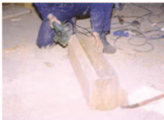
Рис. 3. Підготовка нової частини до наросування
