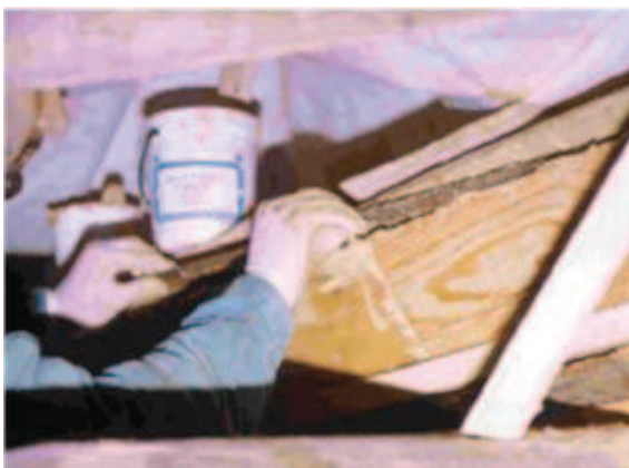
Рис. 5. Нанесення клею в отвори
