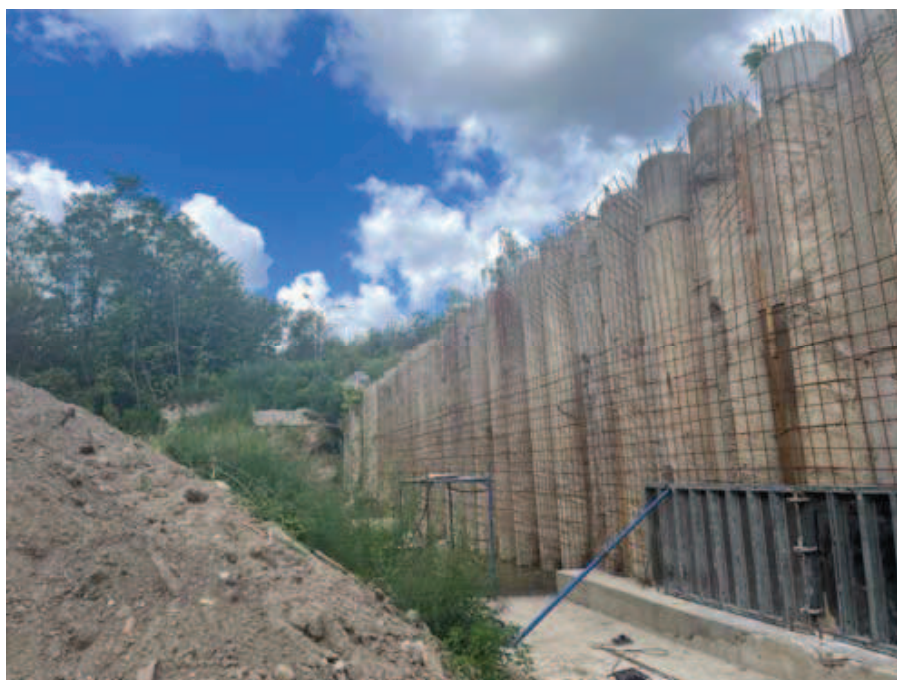
Рис. 4. Загальний вигляд підпірної стінки після виїмки ґрунту котловану.
