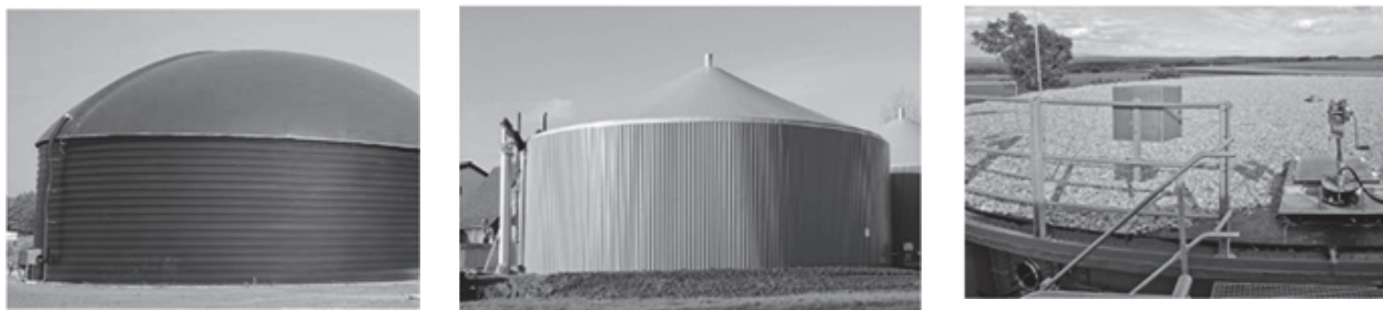
Рис. 5. Конструкції даху пост-метантенків
