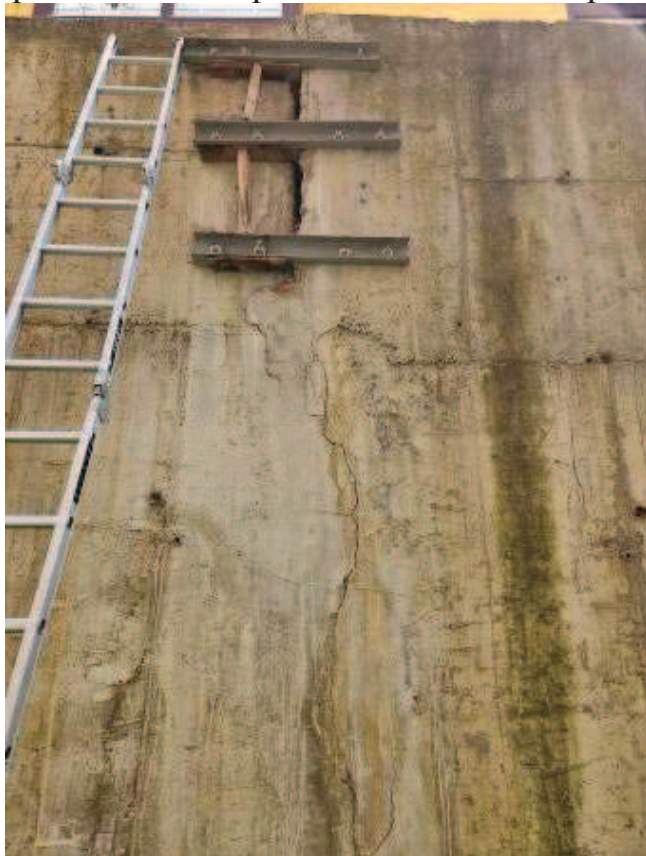
Рис. 2. Тріщина на висоту стінки ПС-1 та зміщення у верхній її частині
