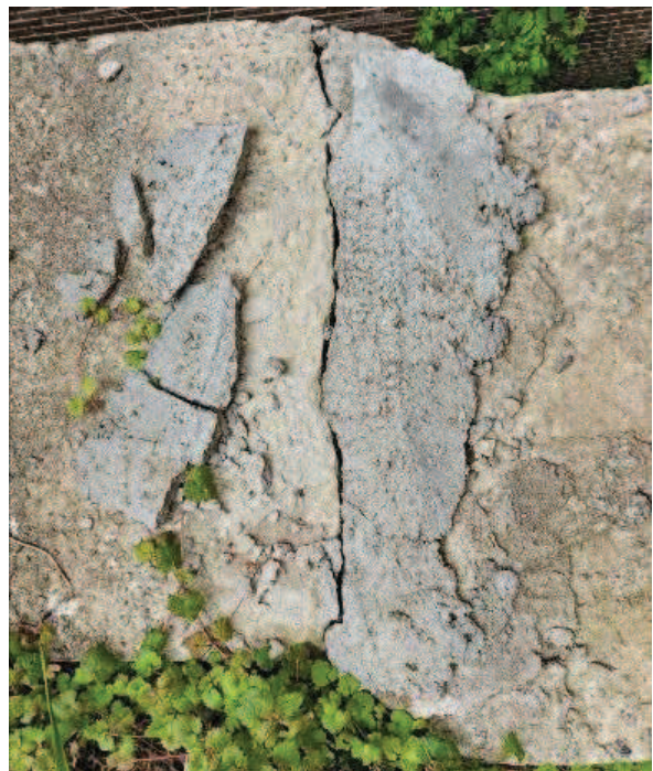
Рис. 2. Тріщина на висоту стінки ПС-1 та зміщення у верхній її частині
