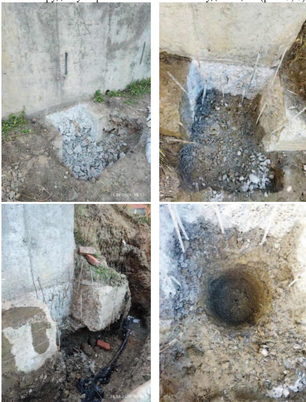
Рис. 5. Підготовчі роботи з влаштування буронабивних паль підпірної стіни
