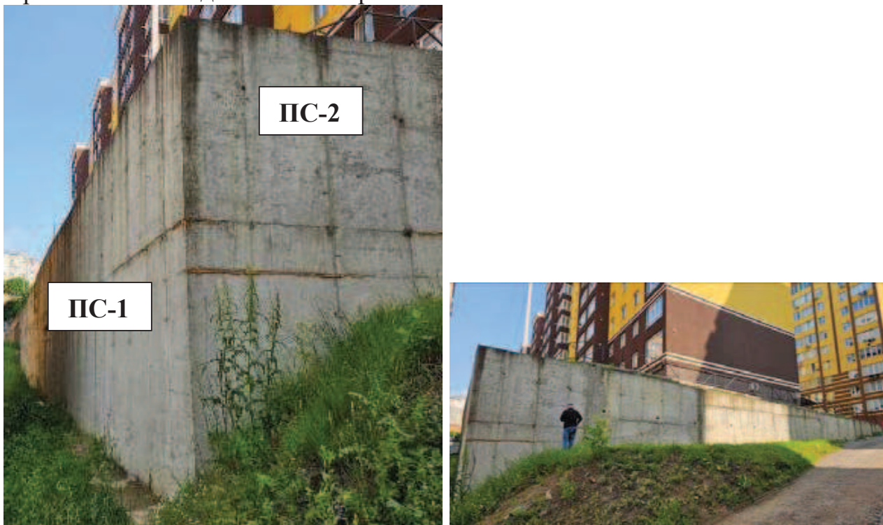
Рис. 1. Підпірна стіна будівництва багатоквартирних житлових будинків
