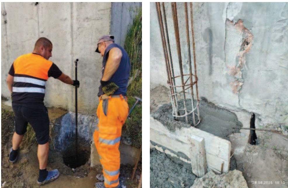
Рис. 6. Влаштування буронабивних паль підпірної стіни
