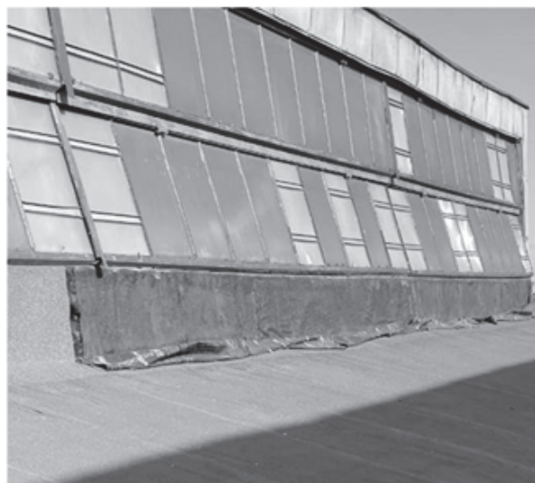
Рис.6. Відшарування примикання покрівлі
