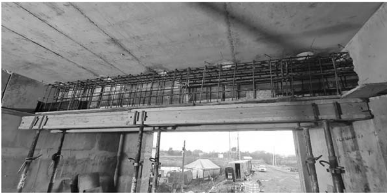
Рис. 9. Влаштування опалубки та бетонування
