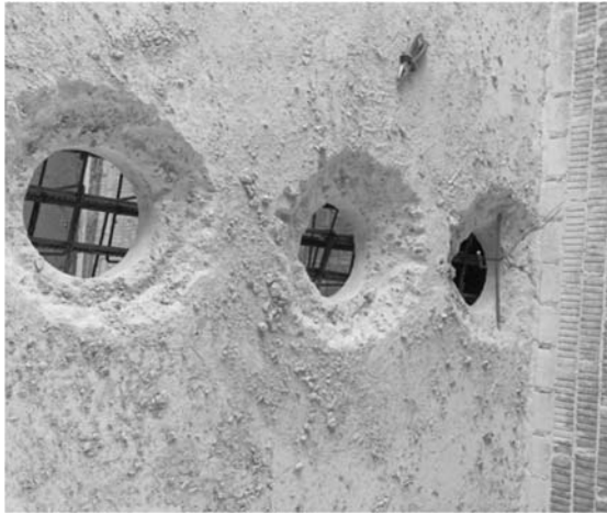
Рис. 8. Процес влаштування отворів
