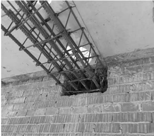
Рис. 6. Арматурний каркас балки
