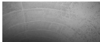
Рис. 2. Зовнішній вигляд сірих і коричневих труб великого діаметру, футерованих дрібнозернистим фібробетоном
