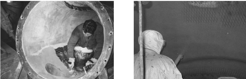
Рис. 4. Нанесення фібробетону на внутрішню поверхню труби методом оштукатурення
