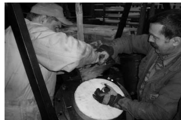
Рис. 3. Нанесення фібробетону на внутрішню поверхню труби з застосуванням вібротильового методу
