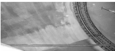
Рис. 2. Зовнішній вигляд сірих і коричневих труб великого діаметру, футерованих дрібнозернистим фібробетоном
