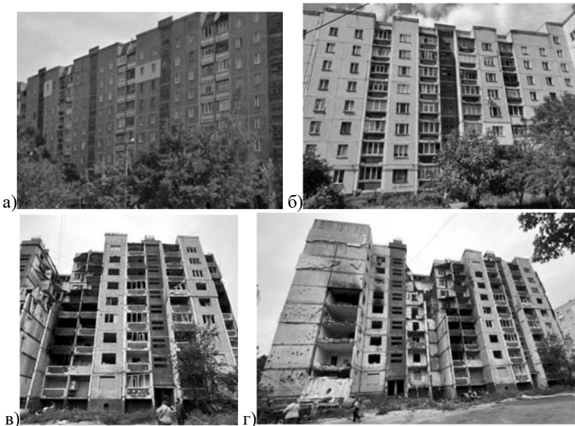
Рис. 1. Фрагменти фасадів крупнопанельних житлових будинків у м. Чернігів до (а-б) та після пошкоджень (в-г)
