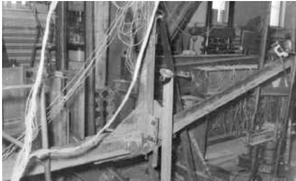
Рис.6. Вузол нижнього поясу ферми з встановленим прогиноміром
