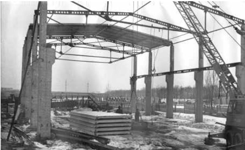
Рис. 10 . Монтаж покриття матеріального складу на заводі залізобетонних виробів в м. Житомирі
