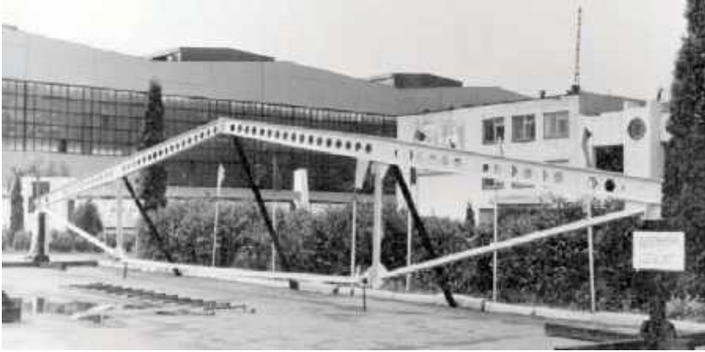
Рис. 2. Зовнішній вигляд малоелементної кроквяної ферми прольотом 18 м з перфораним верхнім поясом змінної жорсткості
