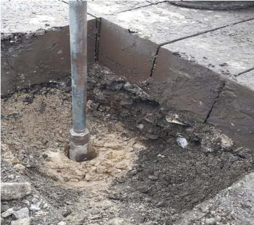
Рис. 4. Фотофіксація з відбору зразків дорожнього одягу та ґрунту основи
