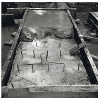
Рис. 5 Процес нарощення перерізу плити
