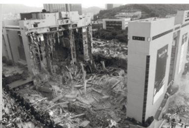
Рис 2 Будівля торгового центру після руйнування
